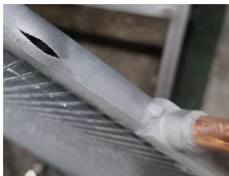
图 15 爆破试验破坏点
